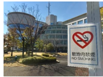
【敷地内禁煙となった市役所庁舎】
