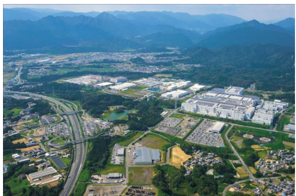
写真：東名阪と工業団地（中央右はシャープ(株)亀山工場）
