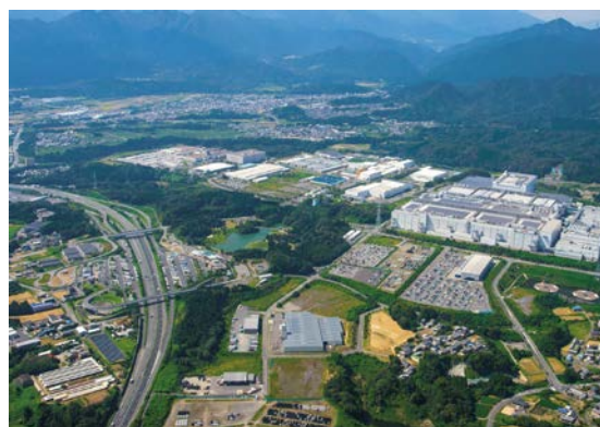
写真：東名阪と工業団地（中央右はシャープ(株)亀山工場）
